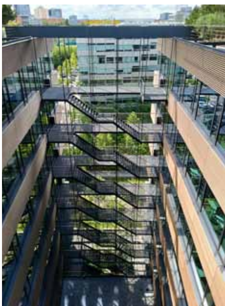
Budova Brumlovky – budova B, Filadelfia a Delta
